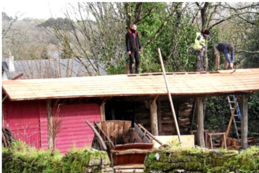
L'écomusée sert de chantier de travail pour ces stagiaires en couverture
